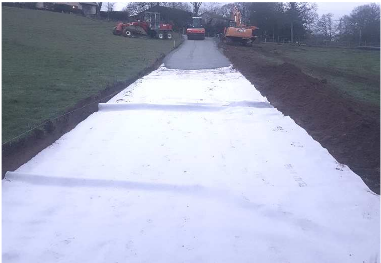
Bild: Als Unterlage für die Holzschnitzel dienen ein Geo-Textil Fliess und eine Schotterbelag.
