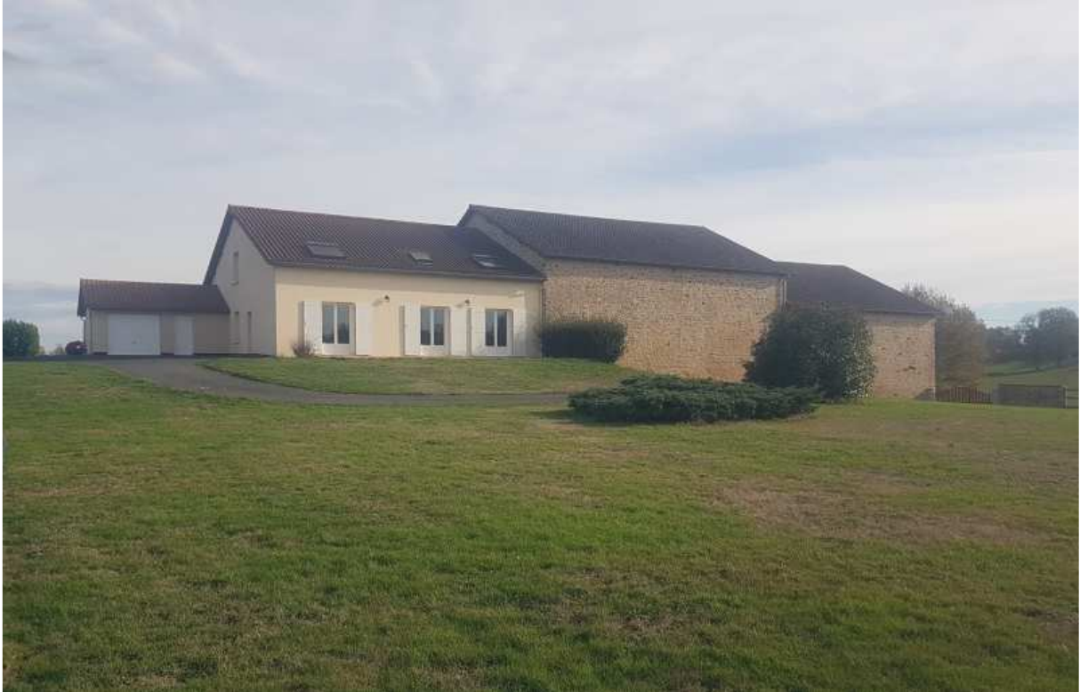
Bild: Mitarbeiterhaus mit alten Stallgebäuden. Im mittleren Trakt befinden sich 6 Abfohlboxen von 5 x 5 Meter.
