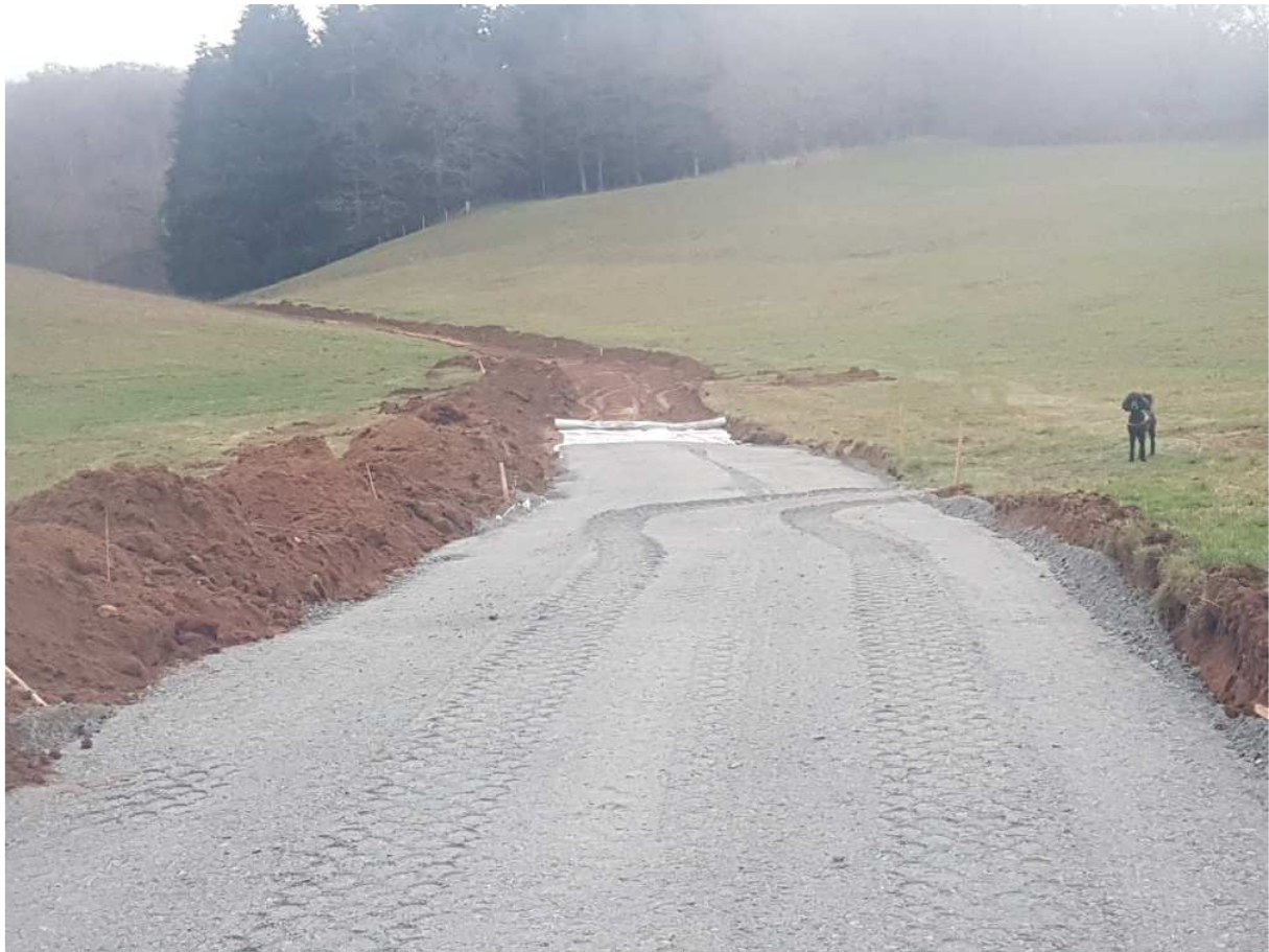
Bild: Im Bau eine Trainingsbahn mit einer Geraden von 1'200 Meter, die letzten 600 Meter ansteigend.
