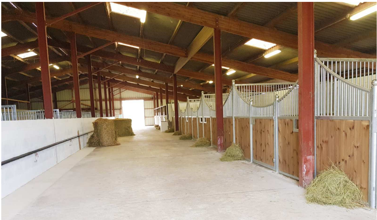
Bild: Ehemaliger Limousin Rinderstall wurde in gut belüfteten Pferdestall mit grosszügigen 26 Boxen umgebaut.
